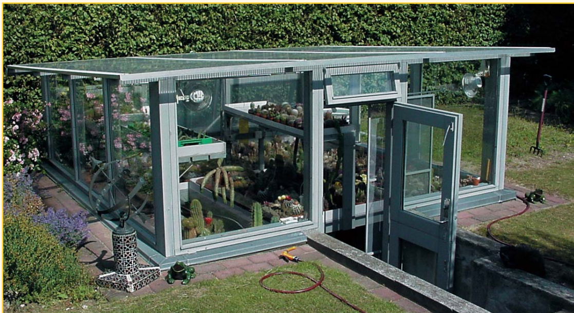
Det nye drivhus er delvist under haveniveau
